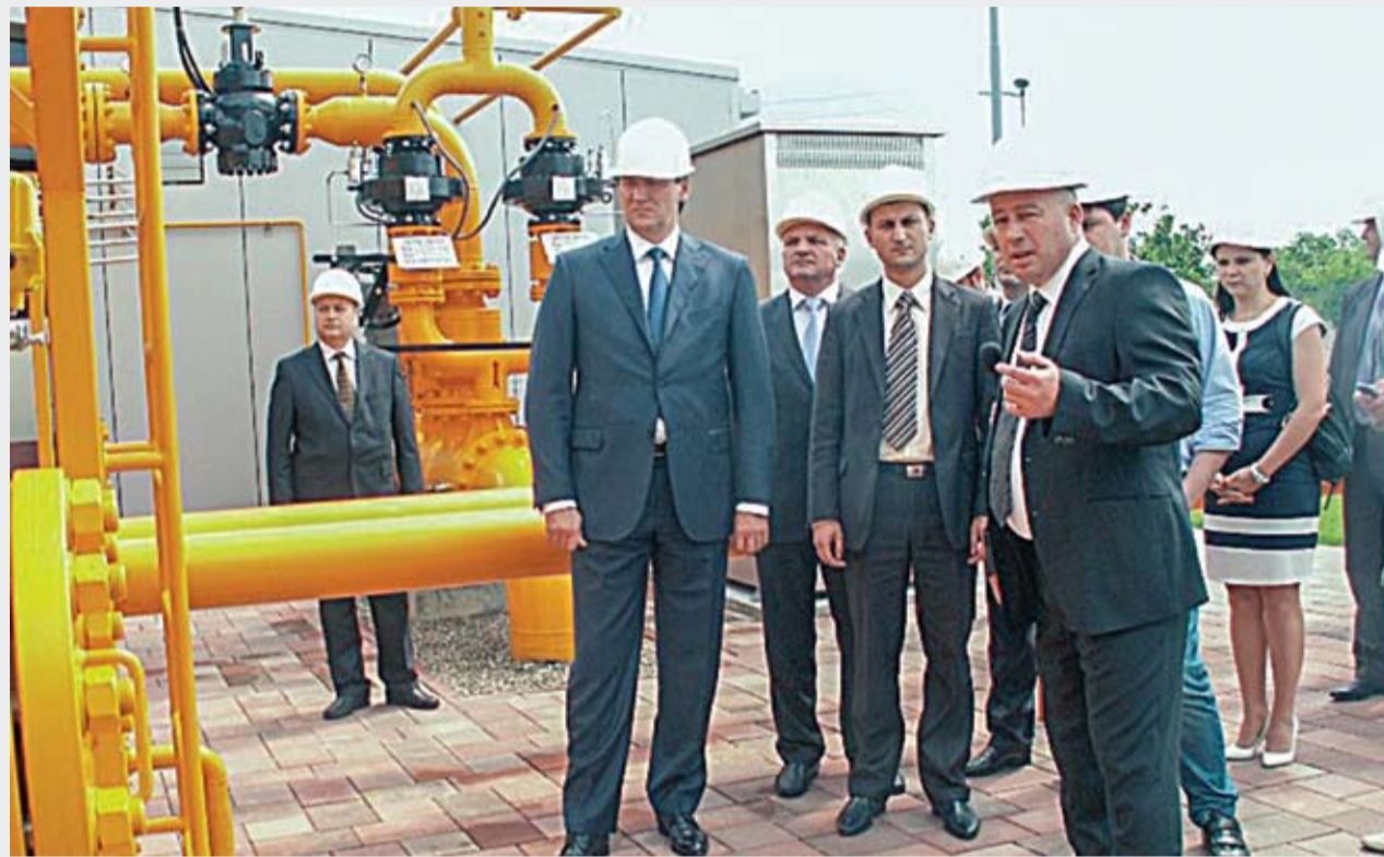
Компания планирует заменить на новые все газораспределительные станции. Фото: пресс-служба АО «Молдовагаз»
